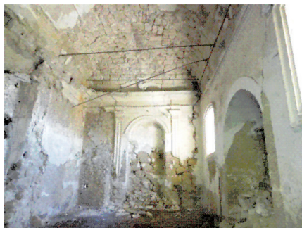
Lo stato attuale della chiesa di Santa Maria in Portosalvo conosciuta dagli ennesi come chiesa di San Calogero
