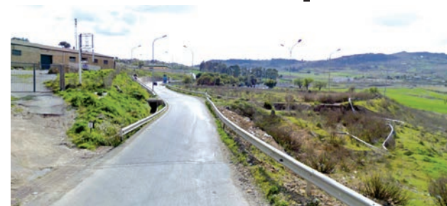
Lo svincolo della SS 626 e i dissesti provocati dal movimento franoso all'altezza di Pietraperzia
