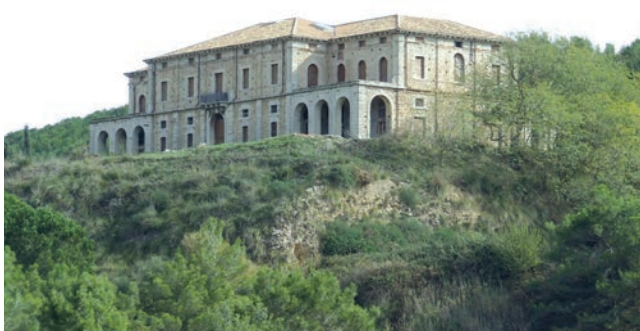
Parco minerario di Floristella Il Palazzo Pennisi
