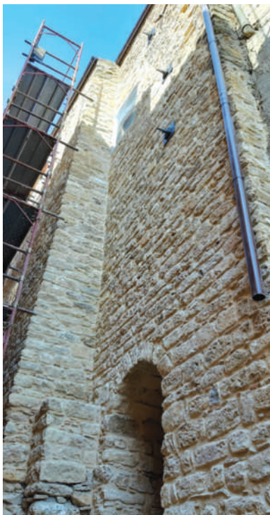
Il muro crollato e ricostruito
