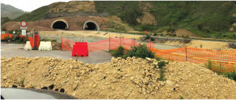
Il cantiere nei pressi dello svincolo di Caltanissetta e la A19
