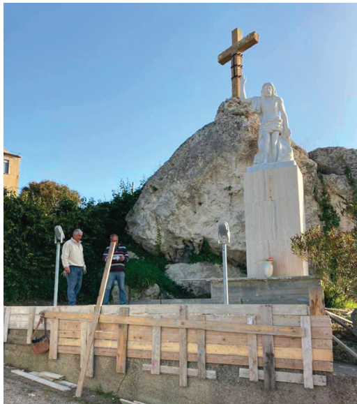
Operai a lavoro nel quartiere San Francesco per ripristinare lo stato dell'arte della Via Crucis
