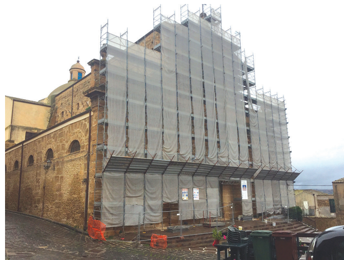
L'impalcatura alla facciata della Madrice a Pietraperzia
