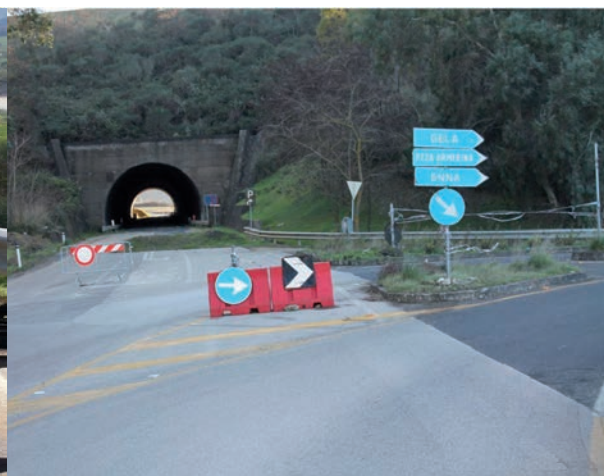
La frana sulla SS 121 e la SP 4 chiusa da 10 anni
