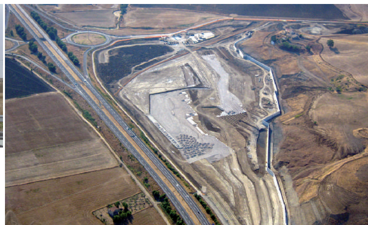
Dittaino - Una foto aerea del costruendo Sicilia Outlet Village
